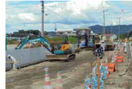
道路築造工事の土工作業風景
